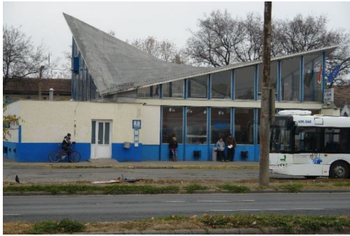
23. kép: A debreceni autóbusz-állomás hiperbolikus paraboloid szerkezetű teteje
