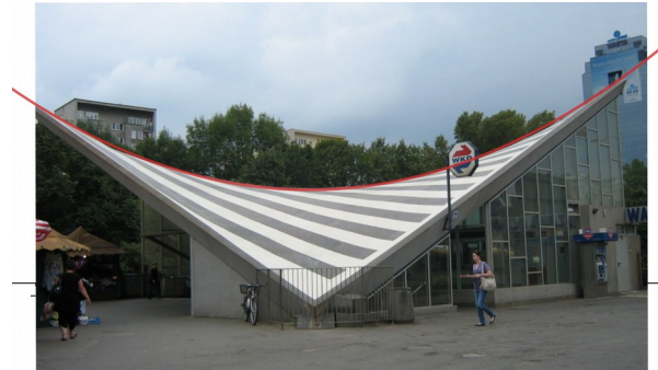
24. kép: Hiperbolikus paraboloid szerkezetű tető. Ocota vasútállomás, Varsó
